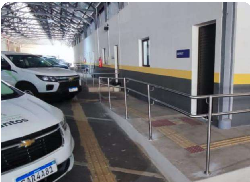
OBRA DE ACESSIBILIDADE DA GARAGEM MUNICIPAL TERMINA EM FEVEREIRO
